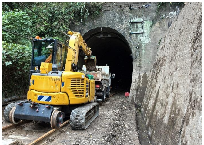
【工事状況】 9月17日
