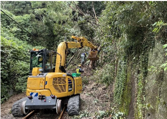
【工事状況】 9月9日
